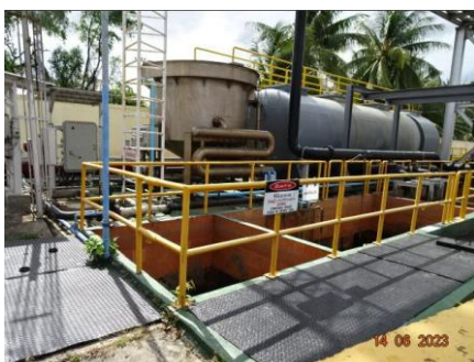
ภาพที่ 2-8 บ่อดักคราบน้ำมัน (Oil interceptor)
